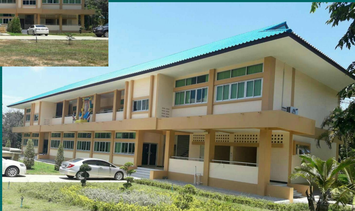
อาคารสำนักงานเขตพื้นที่การศึกษา แบบที่ 4 กรอบอาคาร 14.90 x 48.40 เมตร สูง 8.05 เมตร
